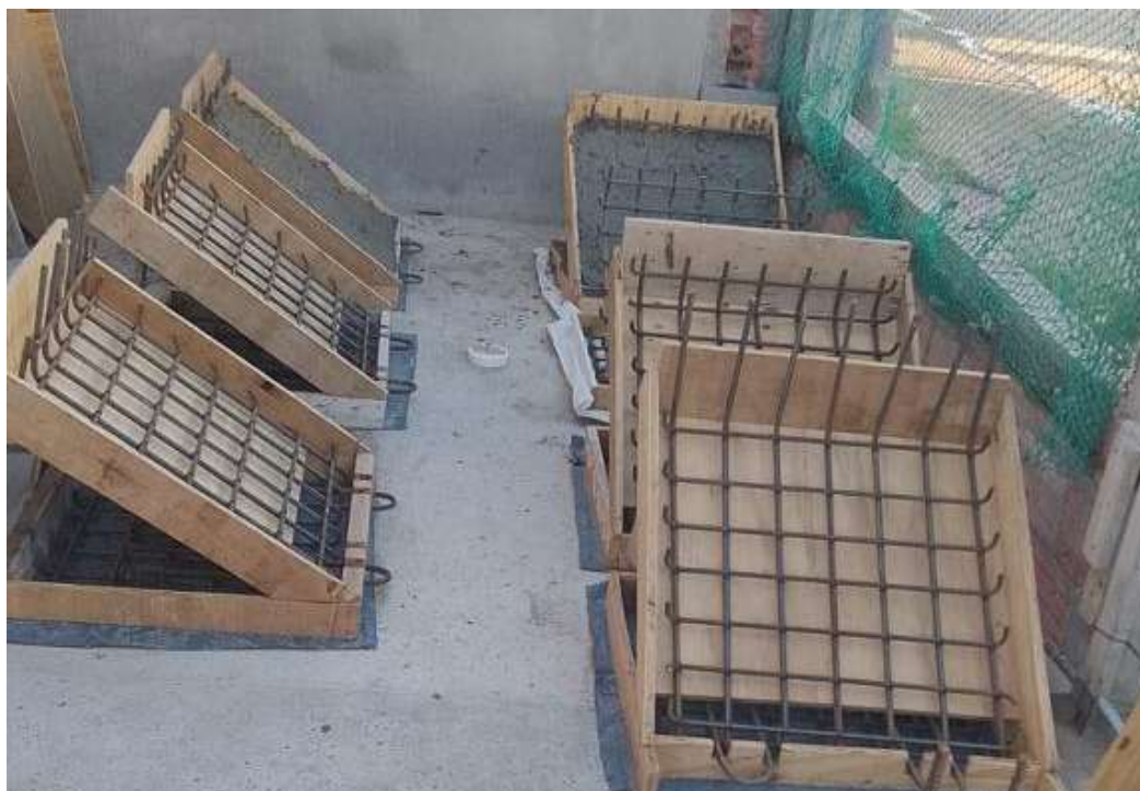
Figura 6. Tareas de armado y relleno de moldes.
