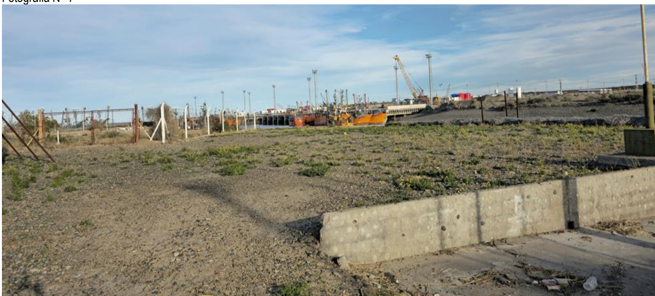
Fotografía N° 8 Aspecto actual del predio en donde se levantará el complejo- Vista hacia el Este
