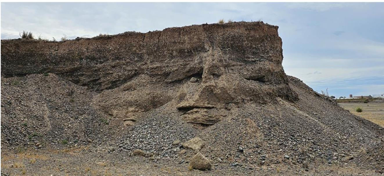
Fotografía N°53 Coluvios y aluvios en frentes con resistencias variables en virtud de cambios de litología y cementación
