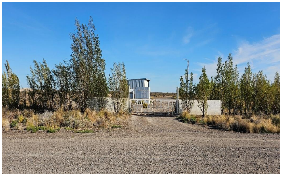
Fotografía N° 2 Ingreso ppal. establecimiento de la empresa Las Bardas S.A S/ruta Prov. N° 1
