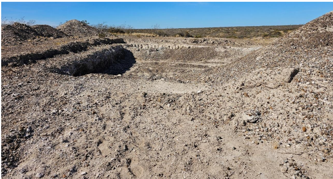
Fotografía N° 29 Extracciones aleatorias para reparaciones de caminos internos del establecimiento ganadero.
