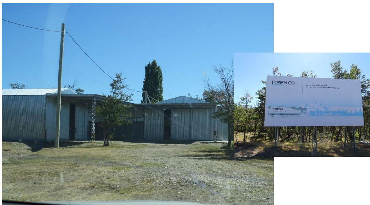
Figura 4.19 Embotelladora Pirengo, vecina del campo (Identificada como Instalaciones 4 en la imagen previa).
