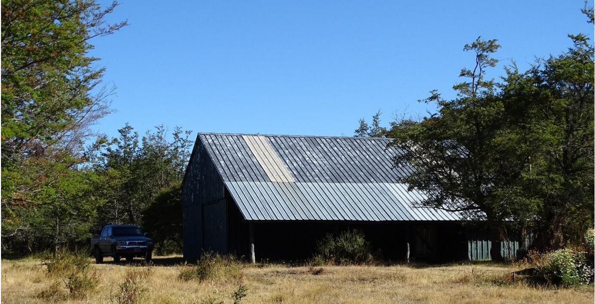
Figura 4.25 Cobertizo del campo Las Vertientes.
